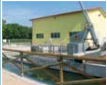
CENTRALE IDROELETTRICA LASA - BOLZANO
